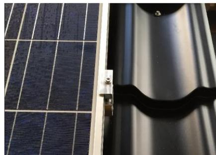
7. Modulabrutschsicherung befestigen, Modulauflegen und Klemmen befestigen
