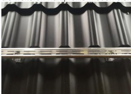
6. Schiene ausrichten und Mutter mit SW 8 anziehen
