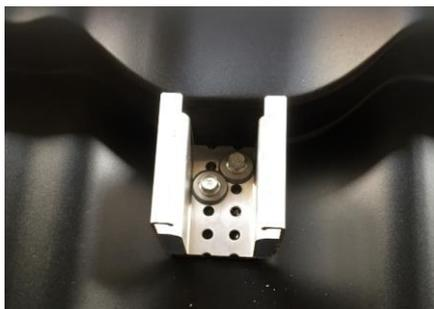
3. Kurzprofil befestigen, Schritte für die weiteren Kurzprofile wiederholen
