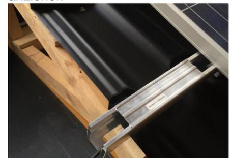
8. C-Schiene kann als Kabelkanal genutzt werden, optional mit Deckel
