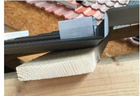
2. Position der Latten ermitteln und Kurzprofil im Wellental mit kürzestem Abstand zum Sparren positionieren
