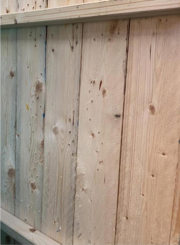
Nach der Demontage der Profile konnte man sehr gut erkennen, wie die Profile sich in die Bitumenbahn eingepresst haben und das Bitumen an dieser Stelle noch trocken war.
