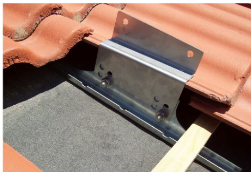
Skruva fast mellandel, fotfäste i tak
