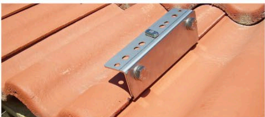
Bild: Kontrollera att urtag i tegelpanna passar
